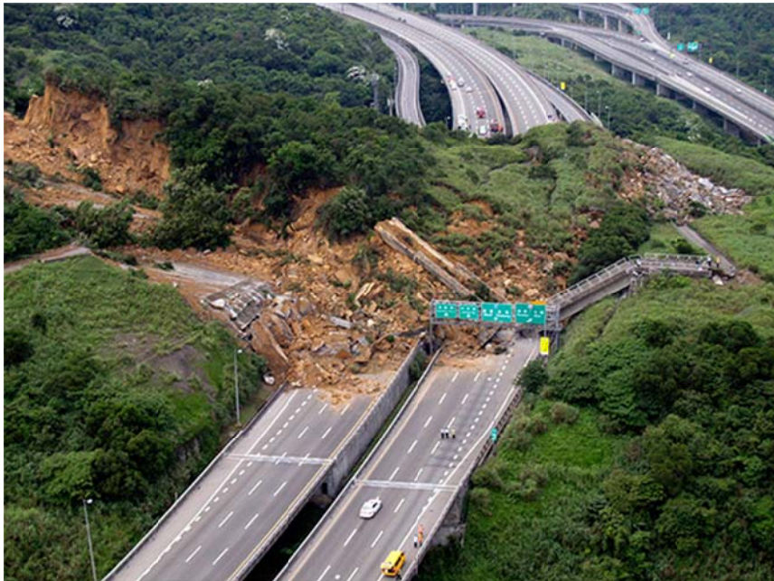
Klizište na auto-putu
