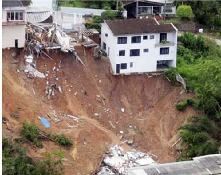
Klizište u naselju
