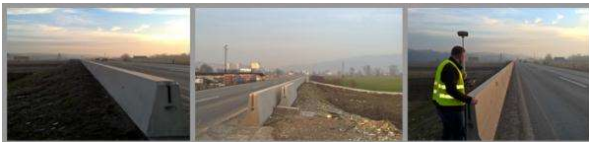
Slika 34 Privremeni sistem zaštite od poplava (cestovna barijera) – primjer iz Doboja
