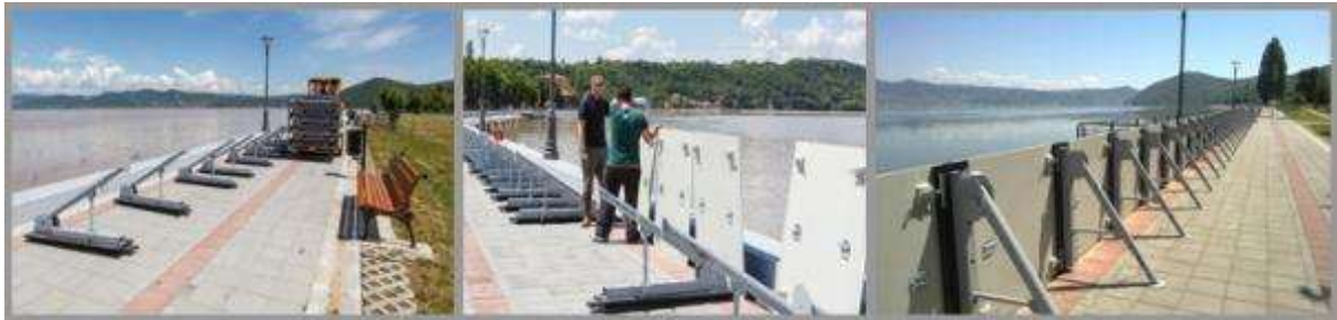
Slika 36 Rasklopivi sistem zaštite od poplava (mobilni paneli) – primjer iz Srbije, Golubac
